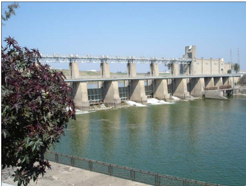
Puente de la Central eléctrica de Alcalá del Río, hoy día.
