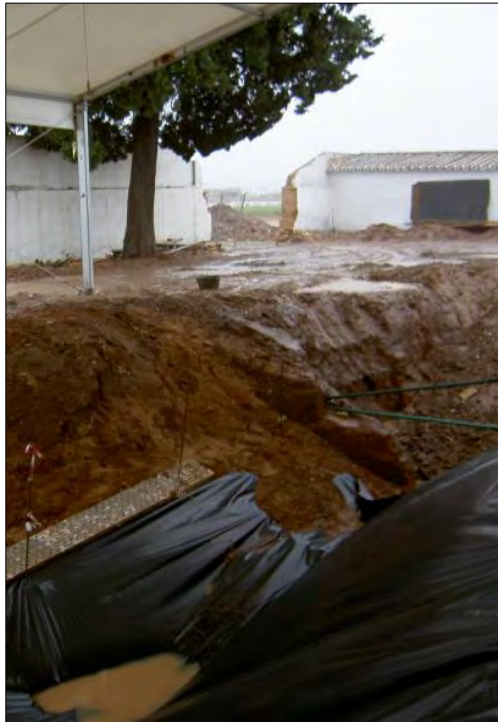
Instalación de plásticos y carpa de protección contra la lluvia
