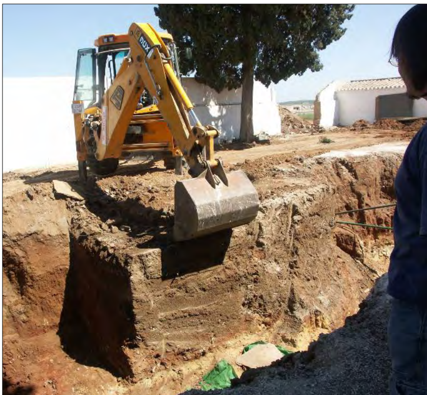
Apertura de la zanja a partir de la zona oeste de la fosa II
