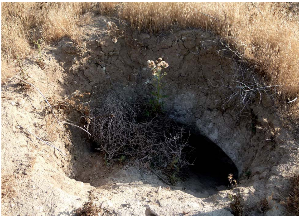
Fig. 16. Aspecto del respiradero de la bodega parcialmente tapado por derrumbe. / Wine-cellar ventilation shaft partially blocked by a collapse.
