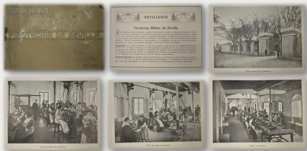
Imagen 8. Folleto sobre la Pirotecnia Militar de Sevilla (Artilería), en el que se aprecia la fachada principal del edificio y la presencia mayoritaria de mujeres en trabajos de elaboración de cartuchería y encapsulado de proyectiles (Madrid, 1909). ATMTSS.
