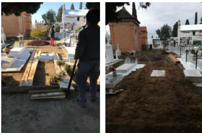
Sector 1. Acondicionamiento del espacio para el acceso de la maquinaria.
