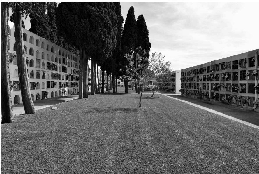
Foto 2: Interior del Cementerio de San Juan Bautista (Chiclana de la Frontera) donde se realizaron sondeos arqueológicos en 2011 en busca de las fosas comunes. Fotografía del autor
