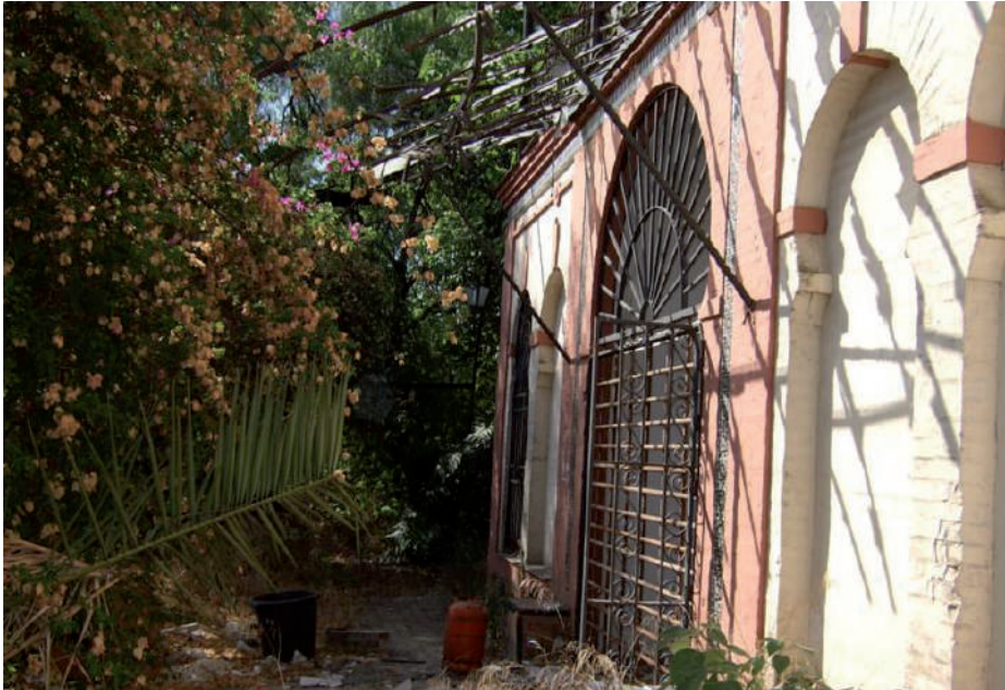
Estado de total abandono en el que se encuentra actualmente Villa Chaboya. Foto: Otto Engelhardt.
