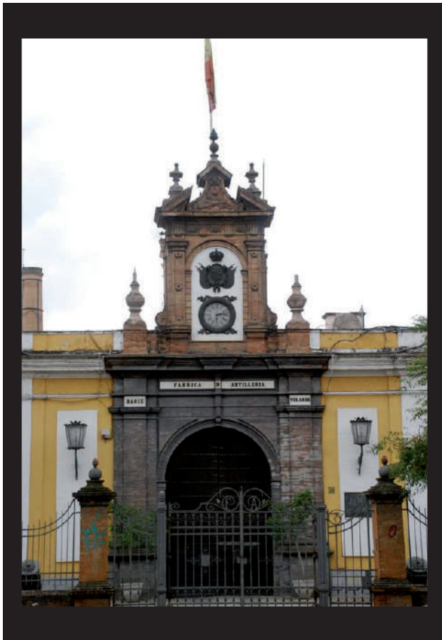
Fachada de la Fábrica de Artillería. Fotografía tomada de Wikipedia [Juanje 2712].
