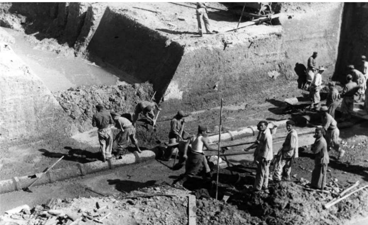
Presos de la 1ª Agrupación del SCPM trabajando en las obras del sifón del Copero. Fuente: CHG/Archivo de imágenes de RMHSA_CGT.A.
