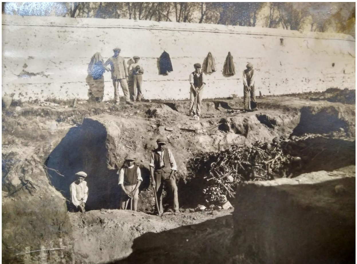
Fotografía 1. Operarios en pleno proceso de exhumación de cadáveres, y realización de los desmontes previos a la acometida de las fosas de obra de hormigón. (Fuente: Archivo Municipal de Lucena).
