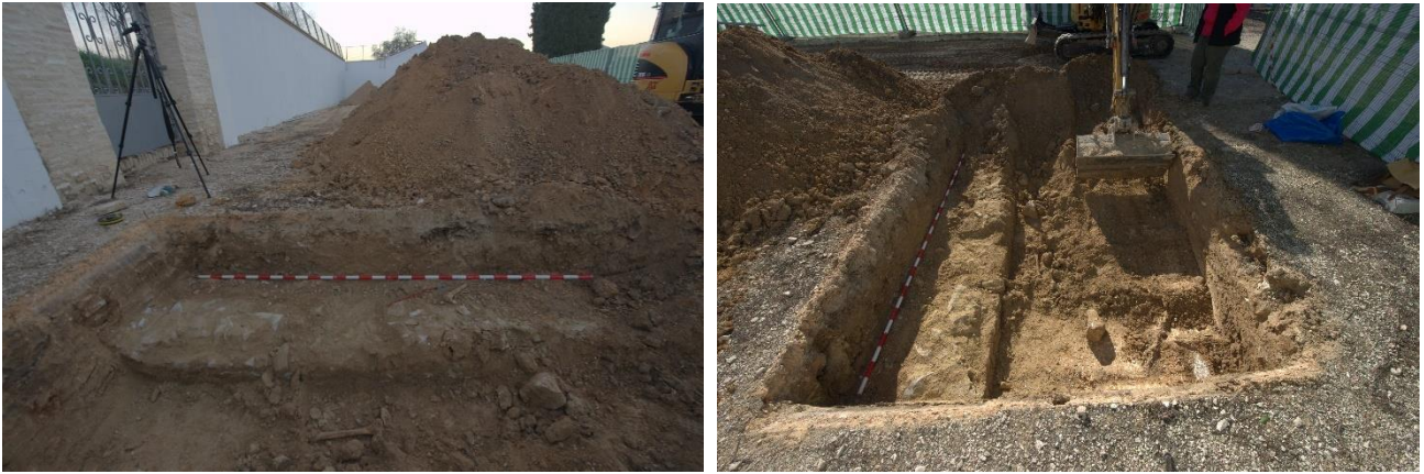
Sondeo 3. Detalles del muro y apertura de catas.
