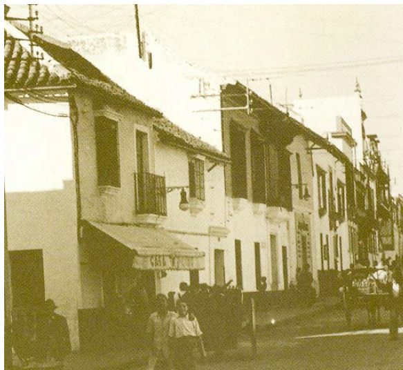
En primer término, con toldo, Casa Troncoso
