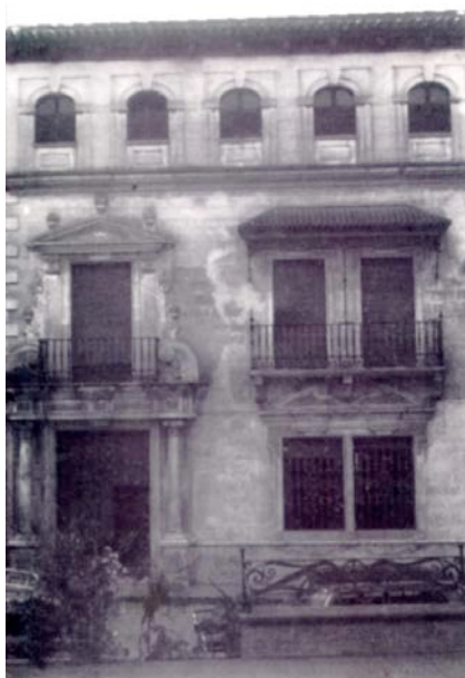
La casa nº 17 de la Plazuela
