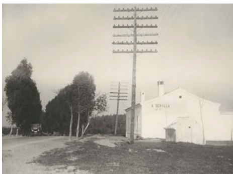
Carretera de Sevilla y casilla de peones camineros de San Benito
