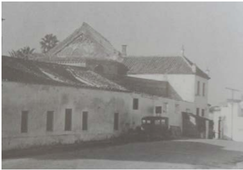
Calle San Francisco. Surtidor de gasolina.
