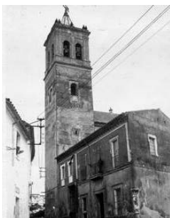
Inicio de la calle Sánchez Perrier
