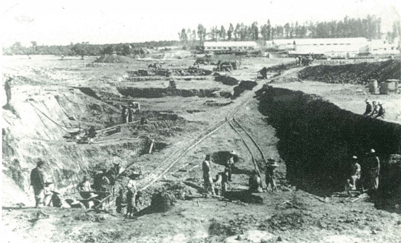
Obras del sifón para salvar la N-IV en la zona de Los Merinales (Dos Hermanas).
