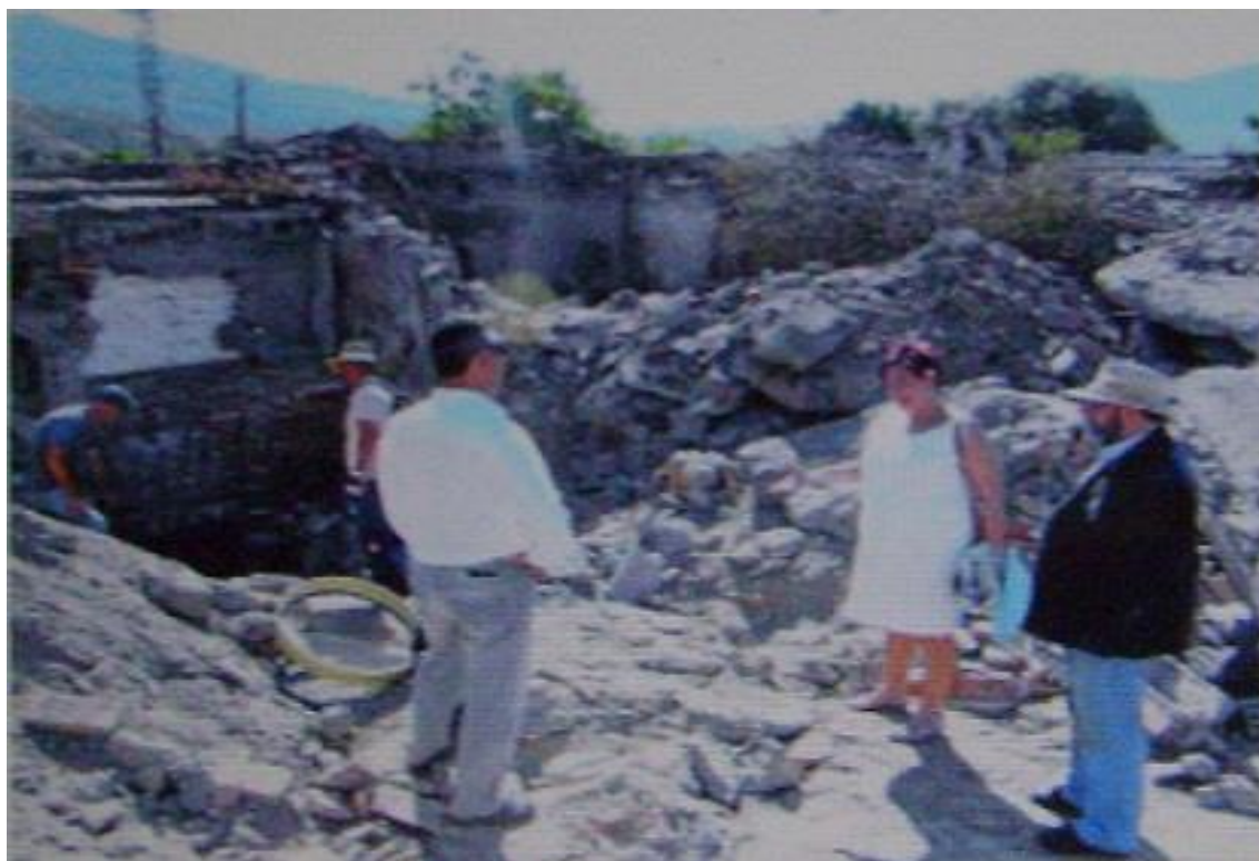
Trabajos de remodelación del terreno del antiguo cementerio de Órgiva. Fotografía Diario Granada Hoy
