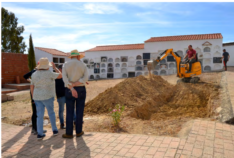
Figuras 3. Vista del inicio de los trabajos mecánicos en el cuadrante superior izquierda del cementerio de Malcocinado.
