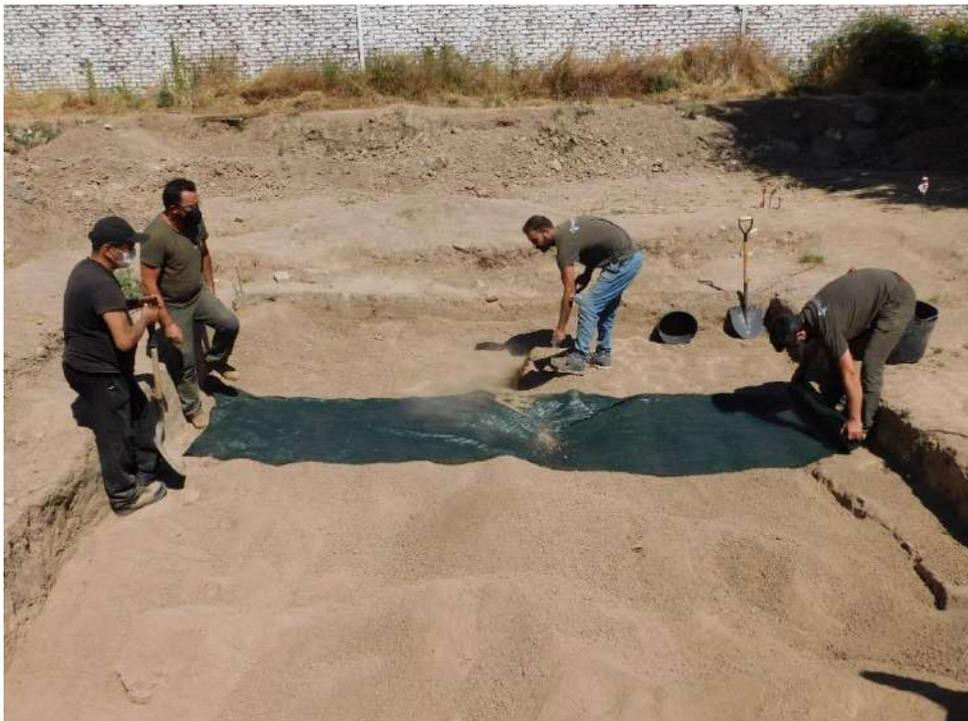
Instalación de malla de protección sobre la tierra fina cribada
